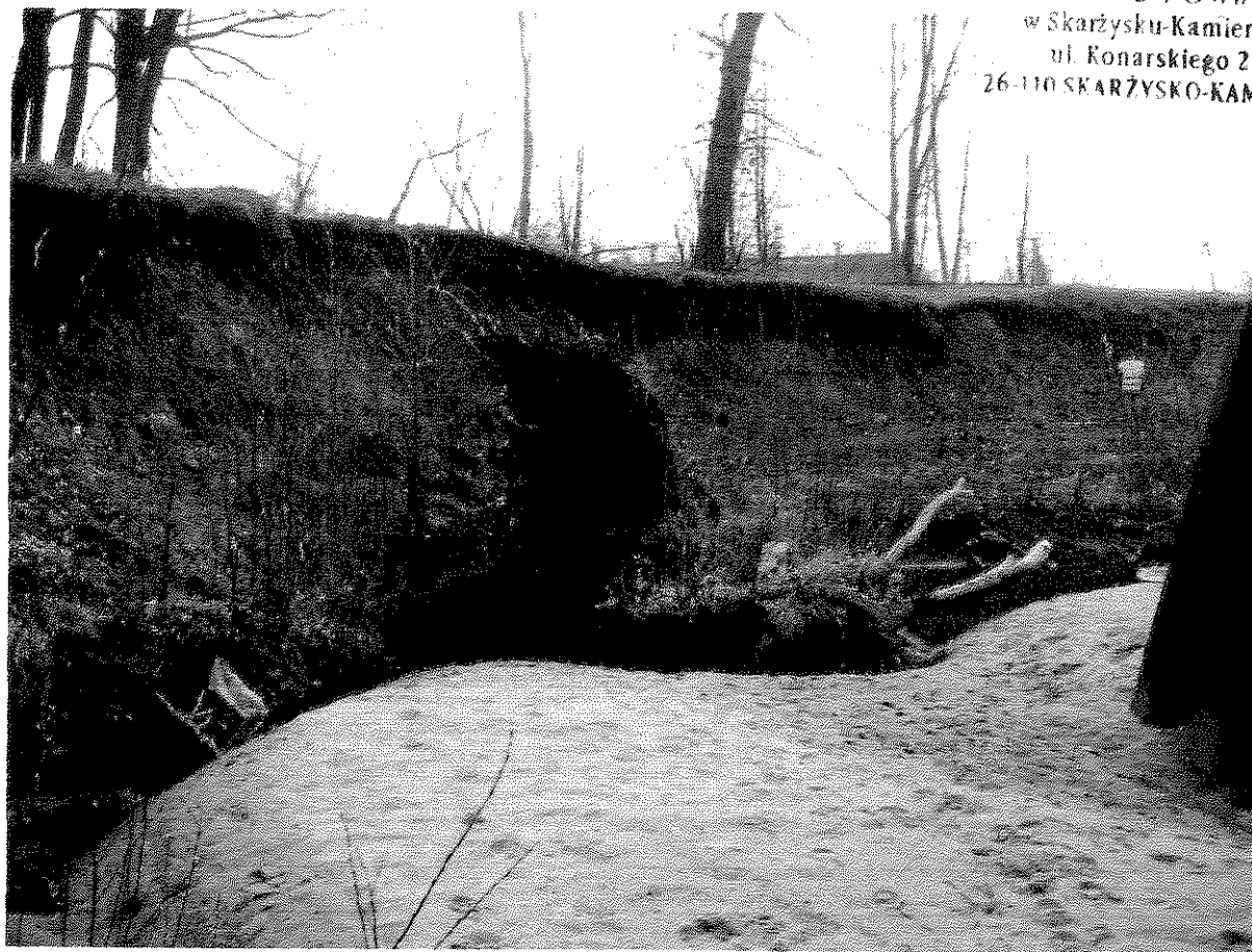
Fot nr 3. Dno wyrwy od strony zbiornika , naniesiony materiał ziemny i powalone drzewa.
