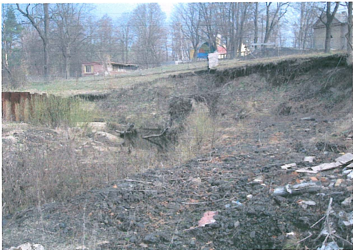
Fot nr 4 . Wyrwa od strony dolnej wody, wypłukany żużel i odpady na dnie wyboju.
