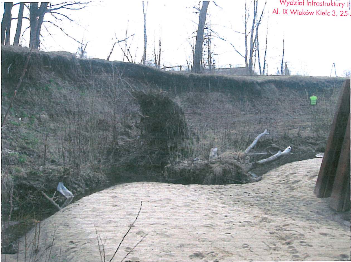
Fot nr 3. Dno wyrwy od strony zbiornika , naniesiony materiał ziemny i powalone drzewa.
