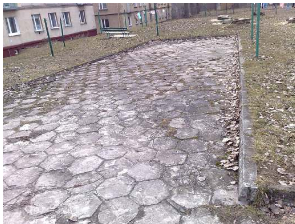
FOT. 5. Istniejąca nawierzchnia parkingu – trylinka.
