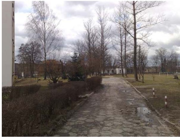
FOT. 1. Droga wewnętrzna dojazdowa o nawierzchni utwardzonej (trylinka) - widok ogólny od strony północno – wschodniej.
