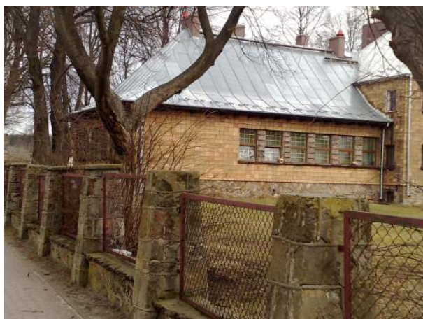
FOT. 3. Fragment elewacji południowej budynku. U dołu widoczny fragment istniejącego ogrodzenia z siatki metalowej w ramach z kątownika na słupkach murowanych.
