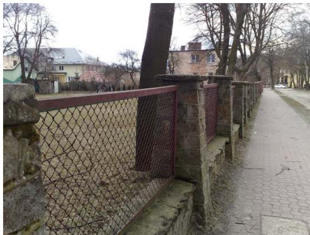
FOT. 5. Istniejące ogrodzenie terenu działki nr ewid. 1538 – siatka metalowa w ramach z kątownika na słupkach murowanych z kamienia. Podmurówka wykonana również jako murowana z kamienia.
