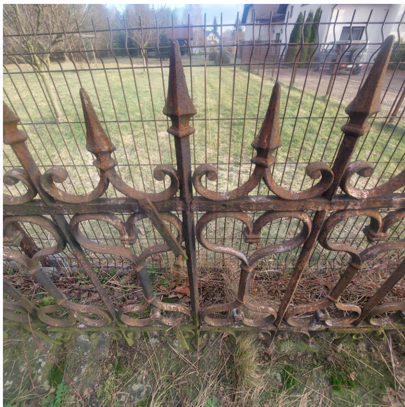
Fot. 11 Korozja pręseł żelaznych
