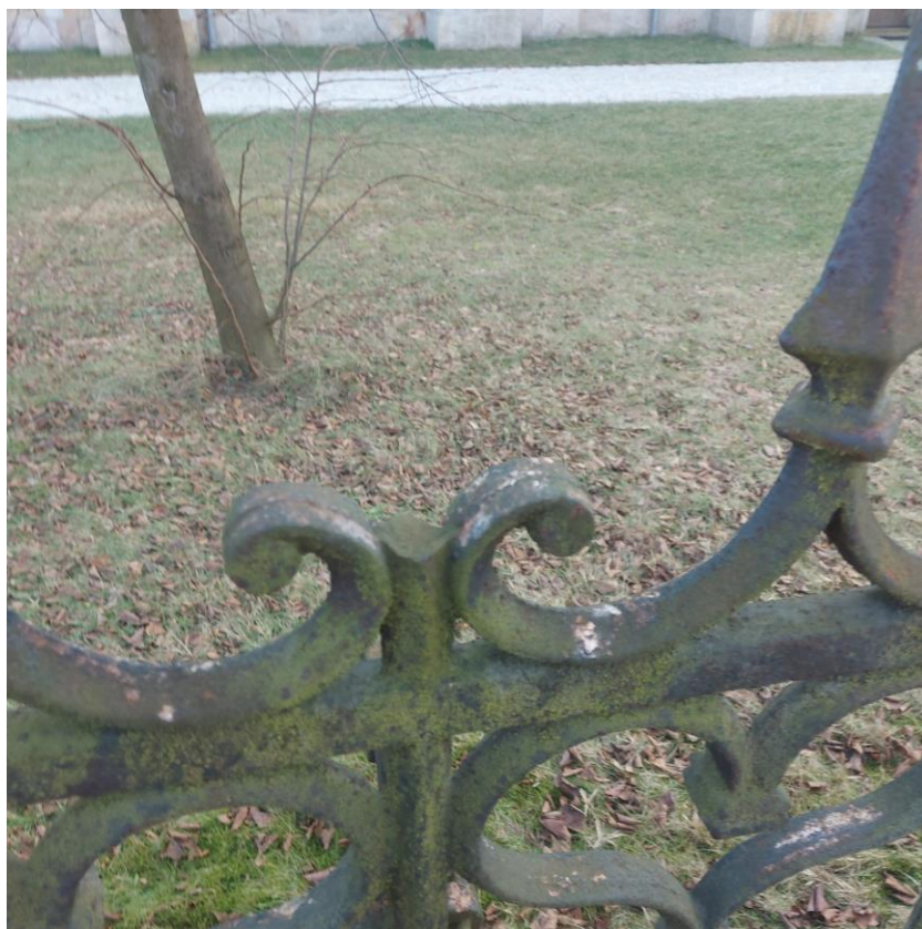
Fot. 12 Uszkodzenia pręseł żelaznych
